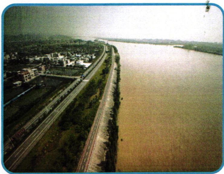
江新联围天河围堤段全景
