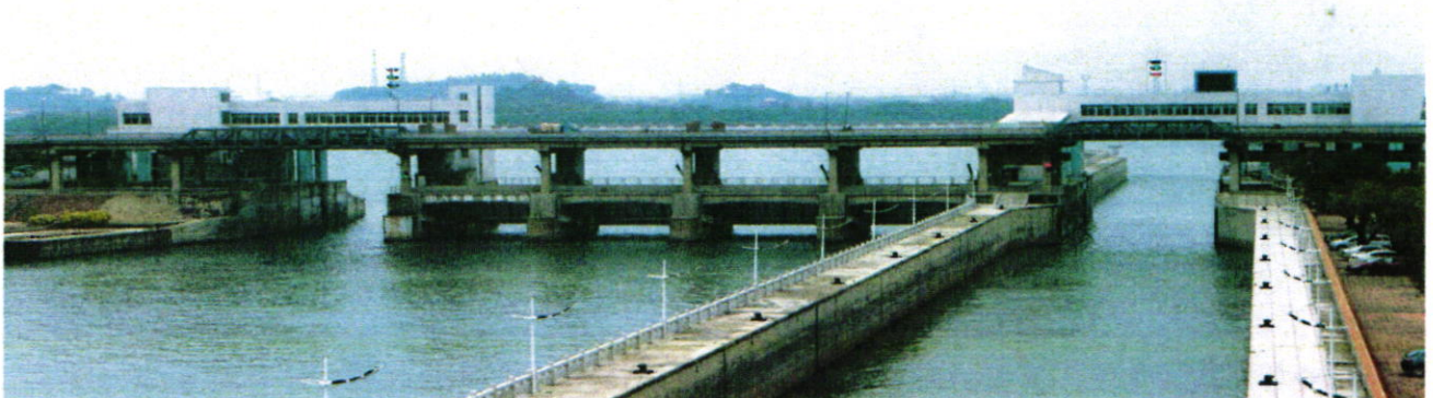
除险加固后的江新联围北街水闸
