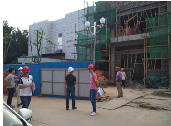
开平市住建局检查开平市医疗急救标准化建设项目
