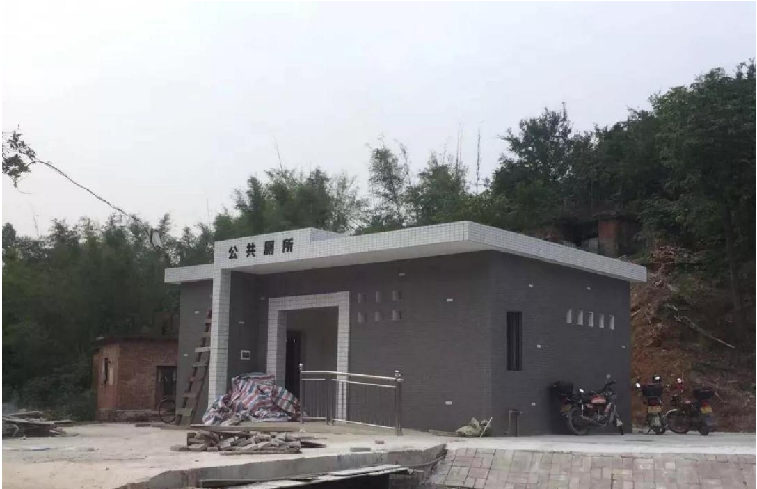
▲杰洲公厕建设
