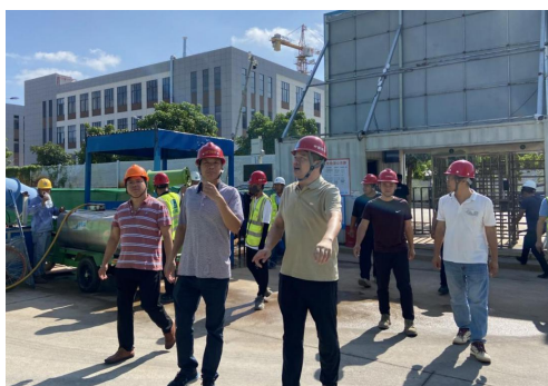
江门市住房和城乡建设局检查 “鹏厦机器人智造园项目”
