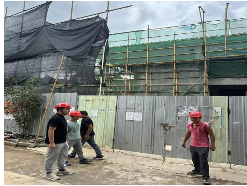
蓬江区住房和城乡建设局检查 “住宅楼危房重建”
