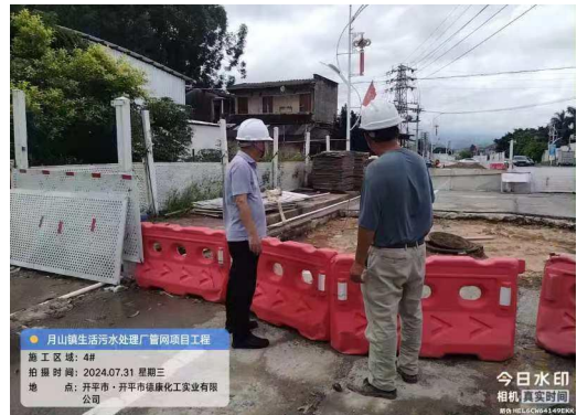
开平市住房和城乡建设局检查“开平市月山镇生活污水处理厂（一期）配套管网工程”
