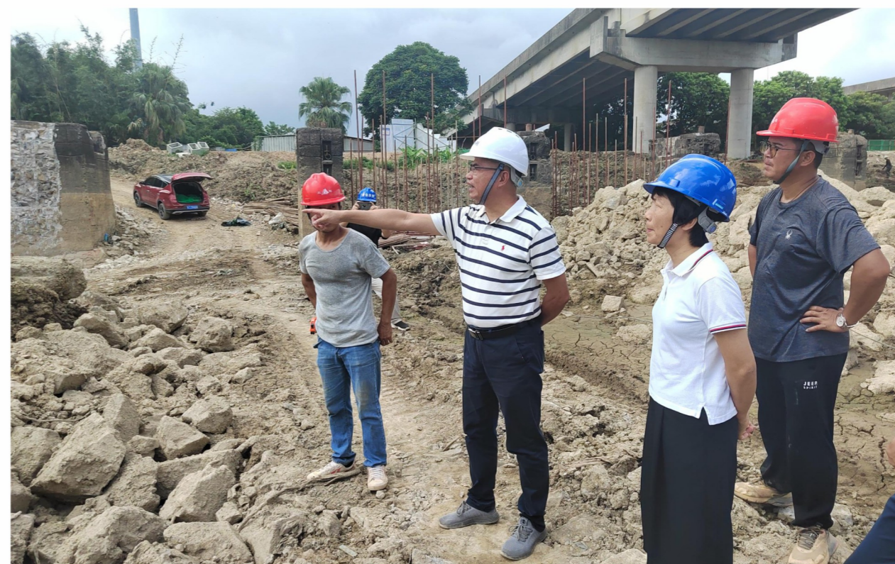
市水利局党组书记刘志方现场检查睦洲水闸工程安全生产工作
