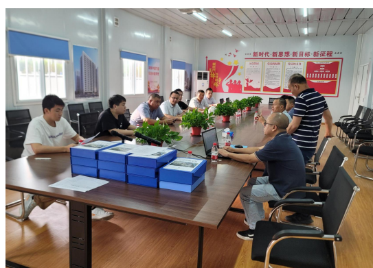
江海区住房和城乡建设局检查“航天华南（安全应急）特色产业基地一标段”
