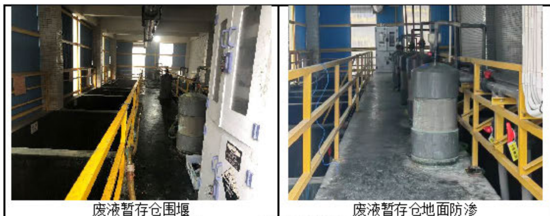
图 1.1.5-33 危废仓现状实拍图
