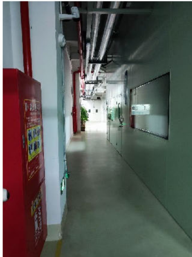
图 1.2.6-4 (b) 2#厂房 5 楼西侧、北侧未设置窗户
