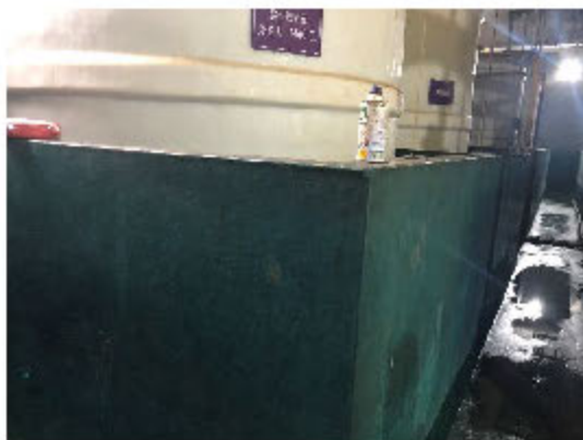
(i) 中央供药系统围堰
