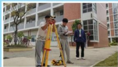
建筑工程测量实训
