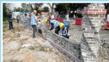
建筑工程施工实训
