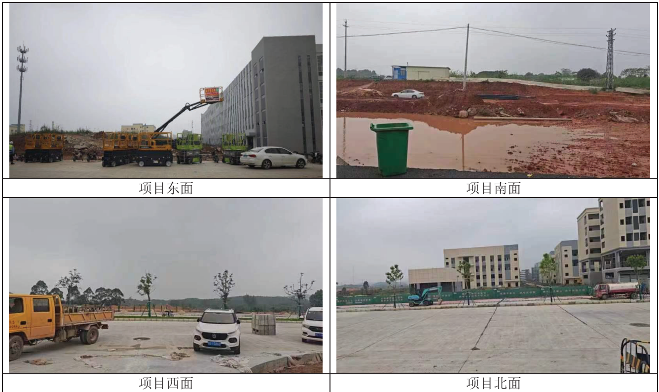
图3.1-1 本项目四至情况实景图
