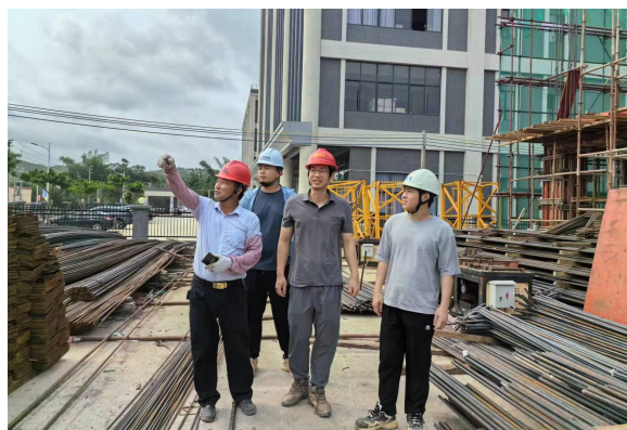
恩平市住房和城乡建设局检查“广东嘉鑫生活用品有限公司厂房及附属设施建设项目”
