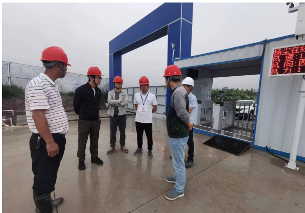
蓬江区住房和城乡建设局检查“蓬江产业转移工业园扩园基础设施建设项目(二标)”
