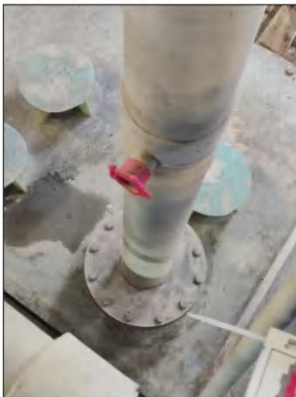
图 4.6-2 原料仓库废气收集方式示意图
