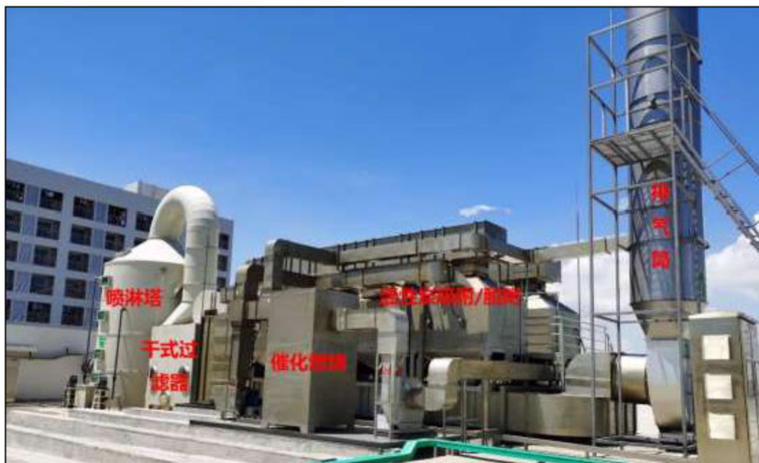
图 1.2.7-6 珠海横达公司有机废气处理措施实拍图
