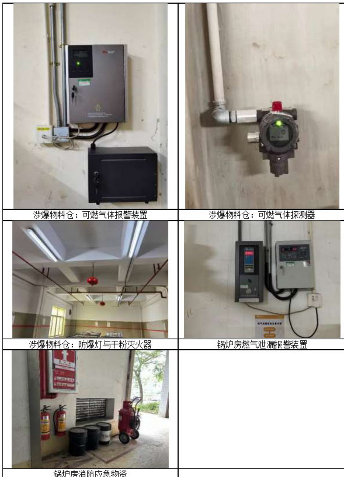
图 3.7-3 化学品泄漏探测与报警系统照片
