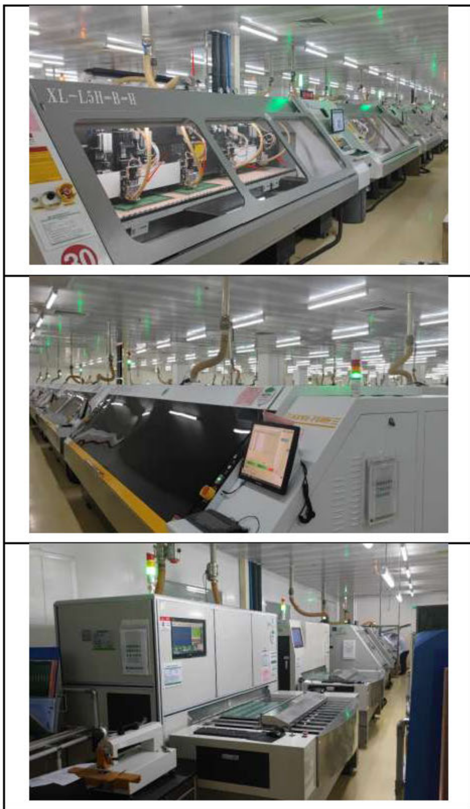
图 1.1.4-5 现有项目钻孔机、V-CUT 机、镗机等集尘措施实拍图
