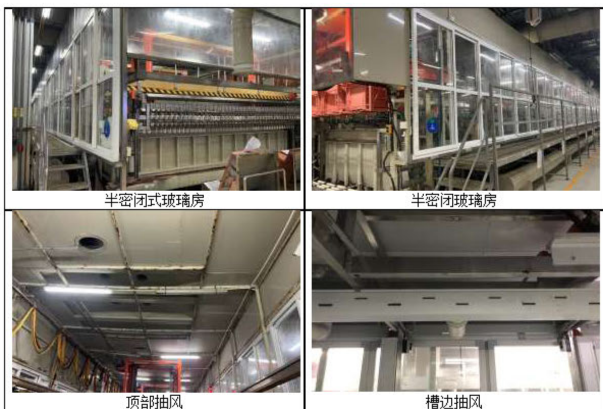
图 1.2.7-1 (a) 垂直电路板废气收集措施实拍图
