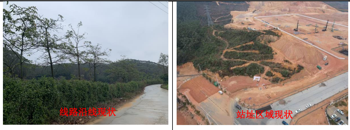
图 3-2 工程区域沿线情况现场照片
