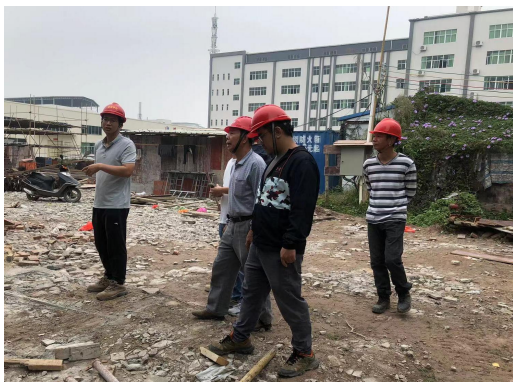
恩平市住房和城乡建设局检查“2# 厂房”
