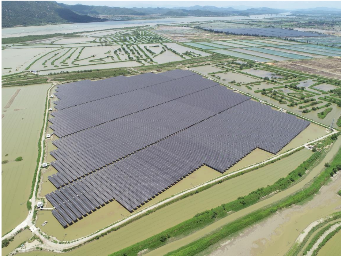
图 2.3.3-1c 光伏现场照片图
