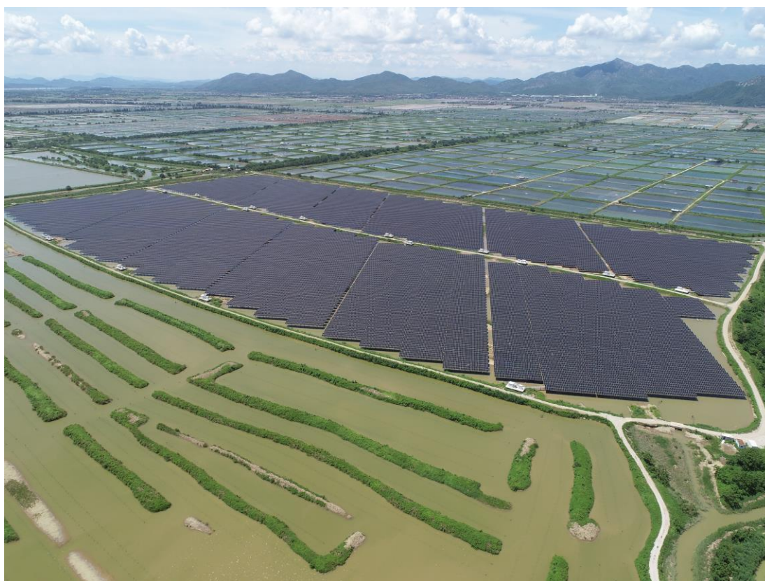
图 2.3.3-1b 光伏现场照片图
