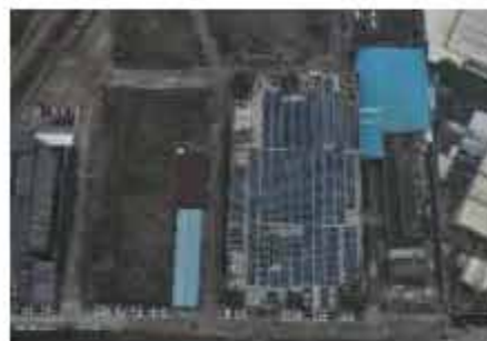
现有项目—印花车间、定型车间、锅炉房
