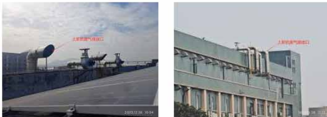
图 3.3-1 上浆机废气排放口现状图
