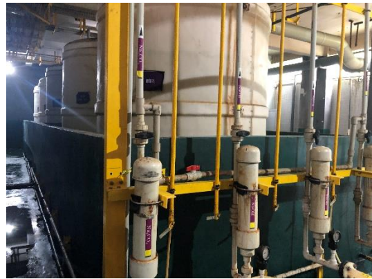
(j) 中央供药系统围堰
