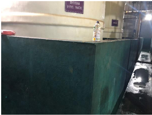
(i) 中央供药系统围堰
