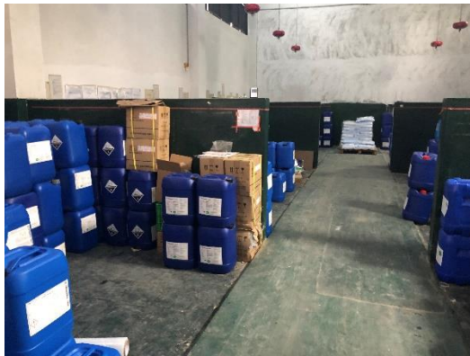
(e) 化学品仓地面防渗措施
