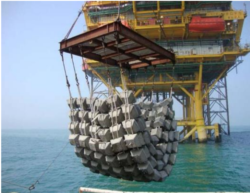
图 2.3.1-8 水泥压块保护示意图
