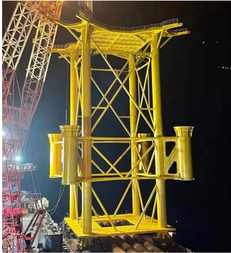
图 2.3.1-3 工艺定位架示意图
