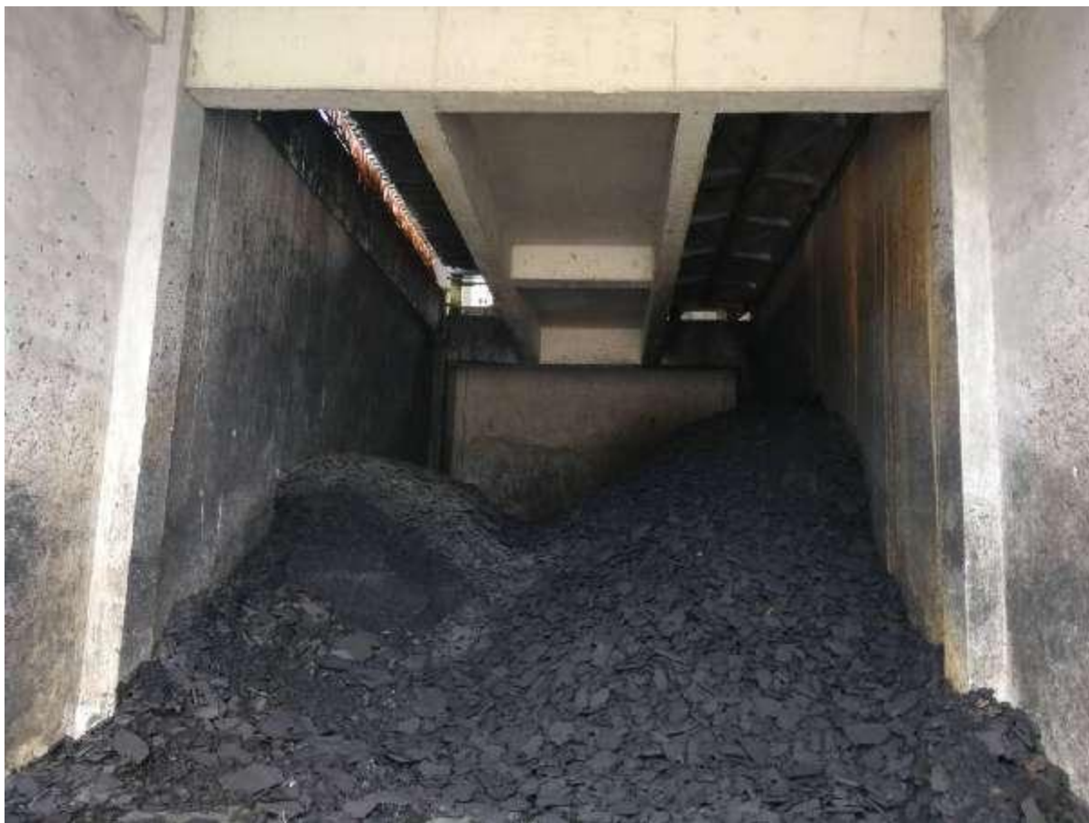
图 2.6-5 现有污泥暂存间
