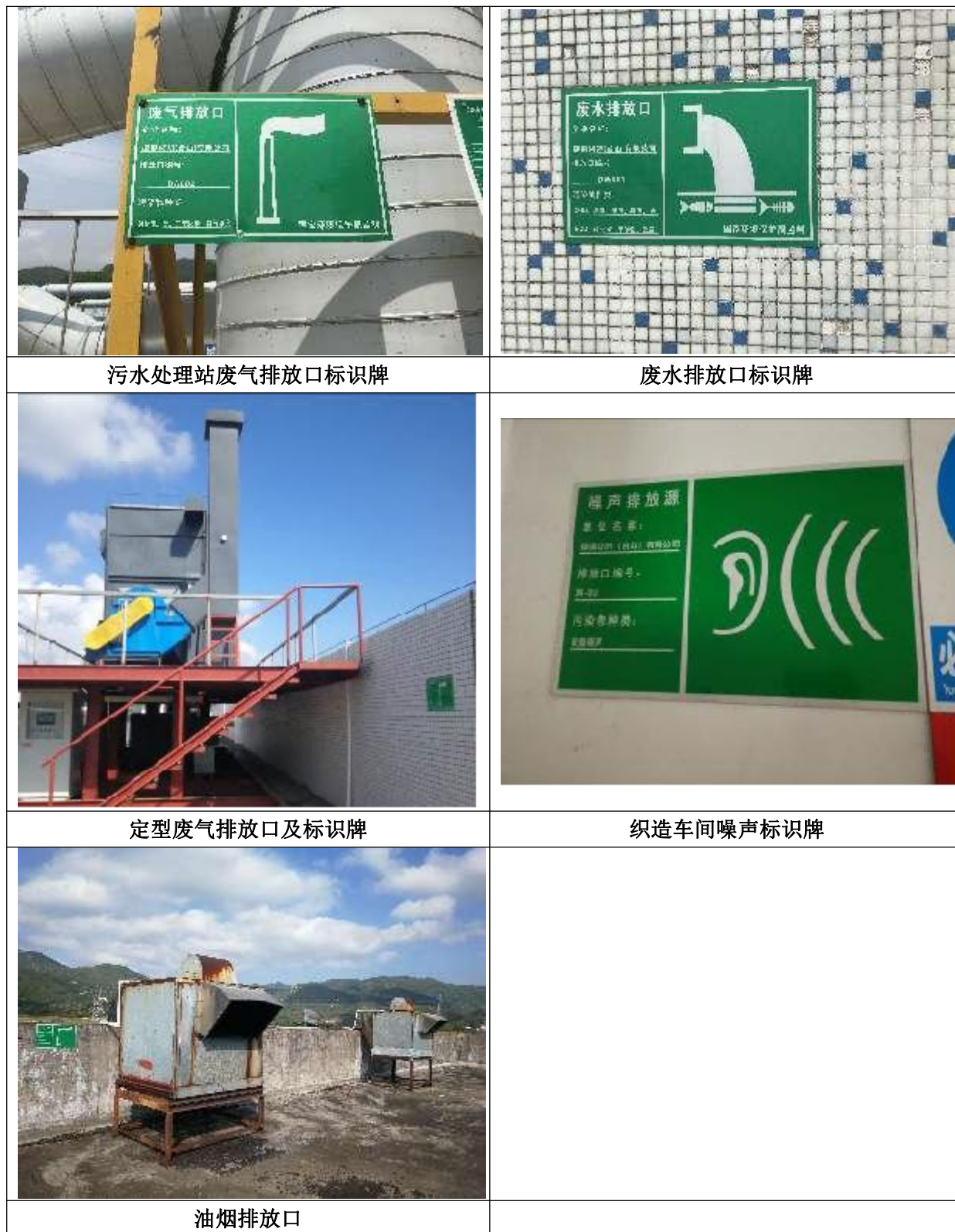
图 2.8-2 现有项目排放口标识牌
