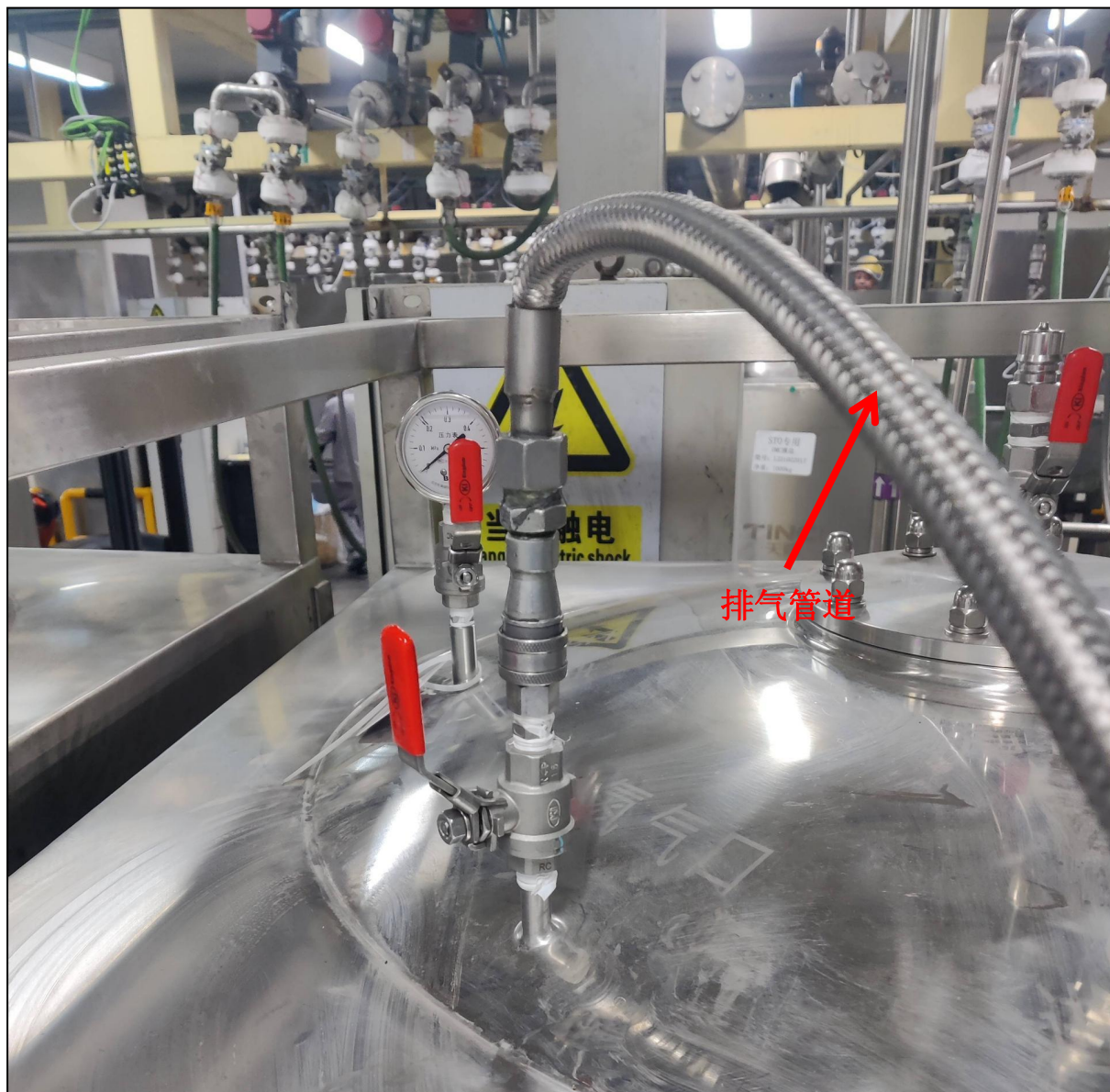
图 6.2-1 项目电解液（包装桶）灌装工序废气收集方式示意图
