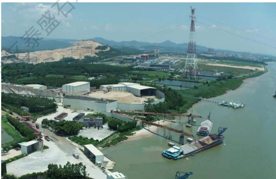
图 5.1.2-5 岸线现状照片
