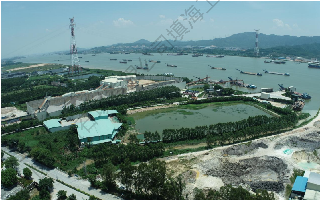
图2.1.2-4 2023年10月现场勘查照片（项目区航拍图）
