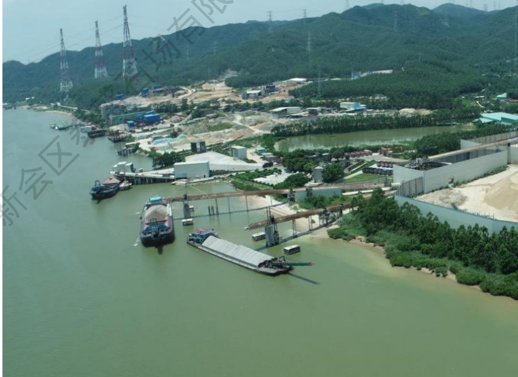
图5.1.2-5 江门市新会区泰盛石场有限公司1#、2#泊位码头工程现状照片
