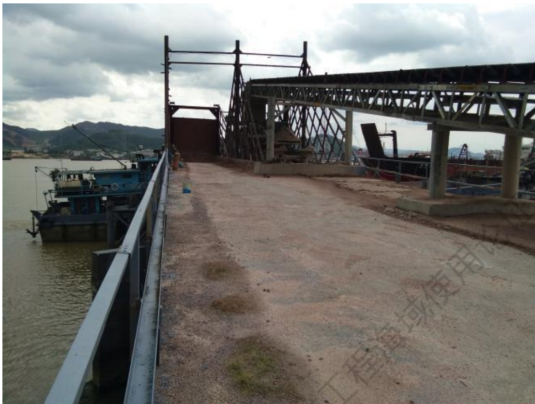
图 2.1.2-3c 2019 年 6 月-7 月现场勘查照片（沙石码头）
