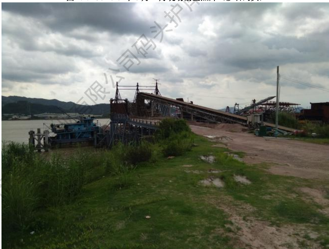
图 2.1.2-3d 2019 年 6 月-7 月现场勘查照片（码头后方）
