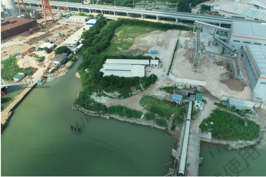
图 5.1.2-7 岸线现状照片
