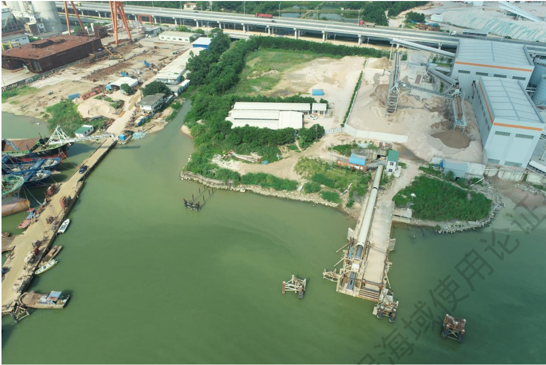
图 2.1.2-4 2023 年 10 月现场勘查照片（项目区航拍图）
