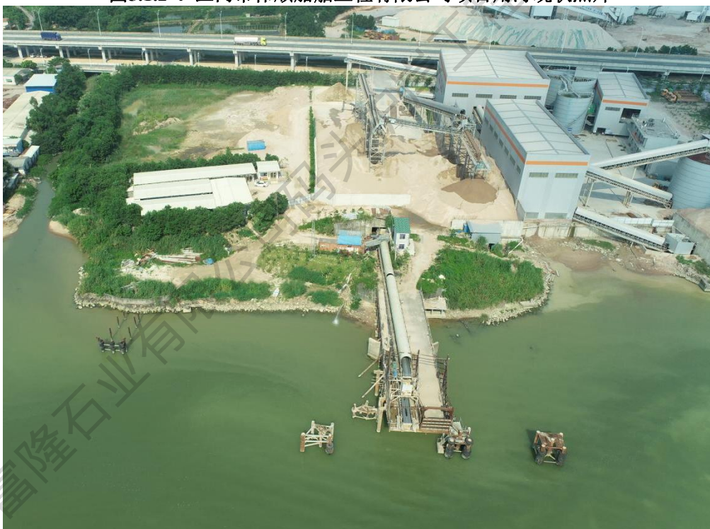
图5.1.2-5 富隆石场码头1#泊位现状照片
