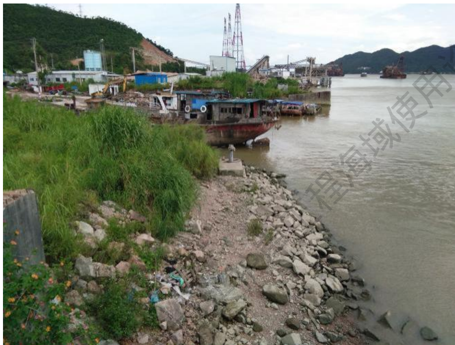
图 2.1.2-3a 2019 年 6 月-7 月现场勘查照片（码头南侧护岸）
