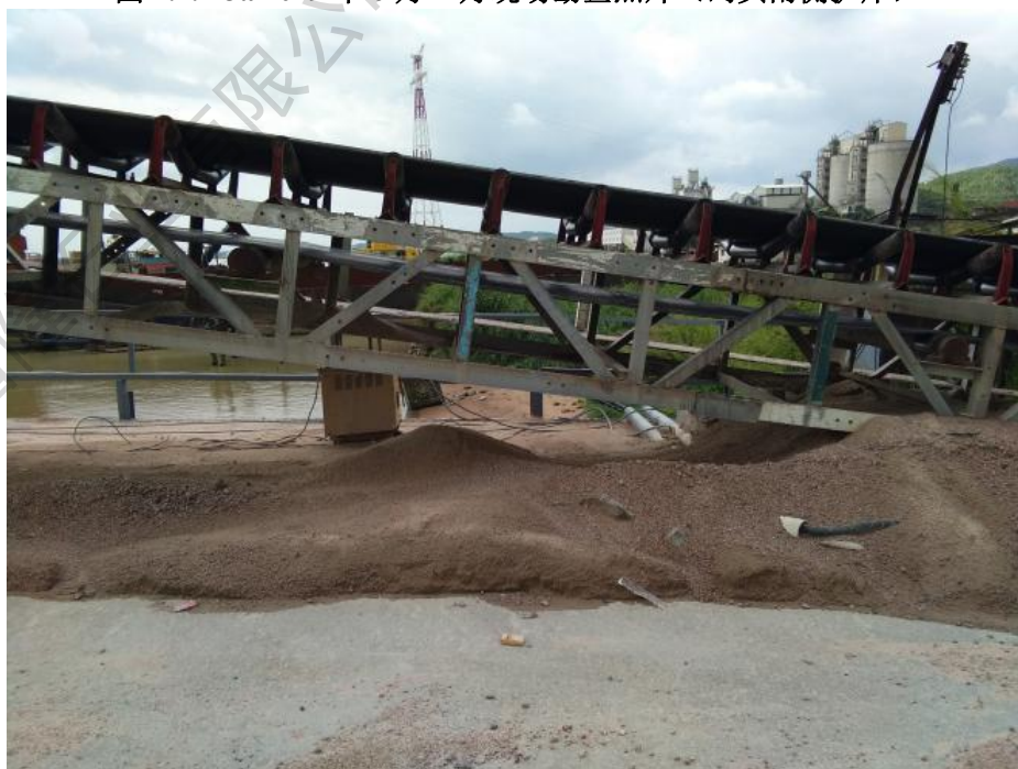
图 2.1.2-3b 2019 年 6 月-7 月现场勘查照片（码头北侧护岸）
