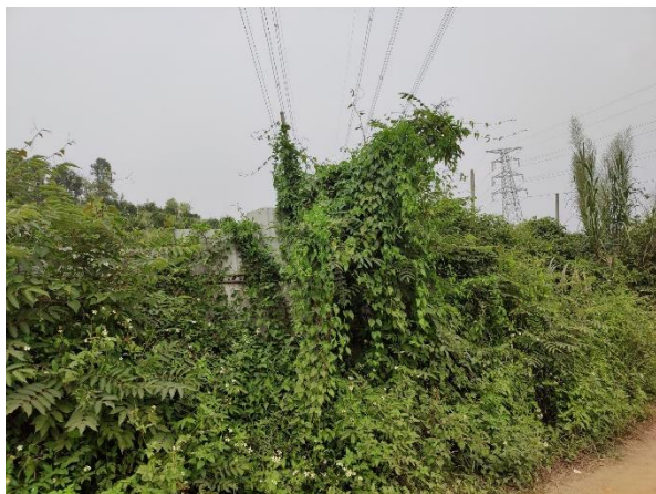
新建电缆线路段（灌木林地）
