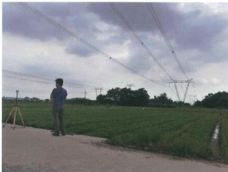
500kV 罗北甲线断面监测
