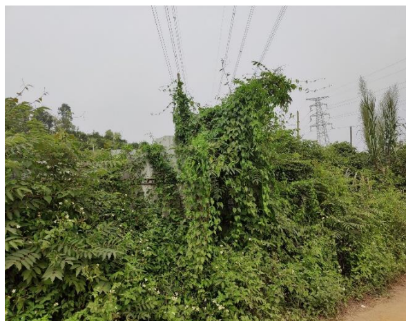
配套 110kV 线路临时供电工程沿线情况（丘陵）
