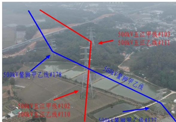
交叉跨越点 3 线路情况（河网）
