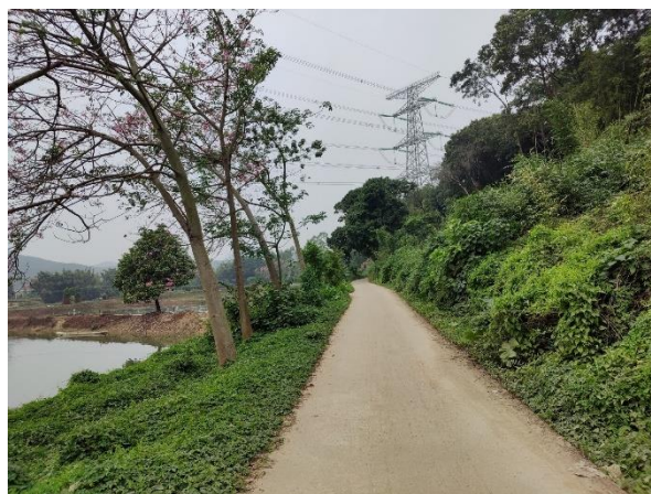
五江甲乙线和鳌狮甲乙线交叉跨越点 3 线路段 （灌木林地）
