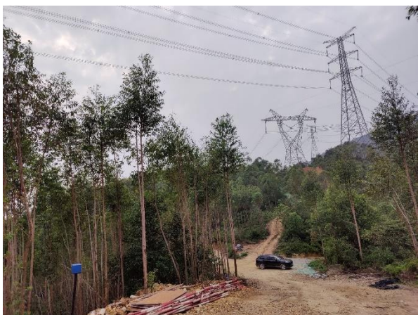
五江甲乙线和鳌狮甲乙线交叉跨越点 2 线路段 （林地）
