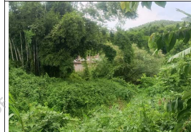
现场照片 3(涵洞出口沟渠)
