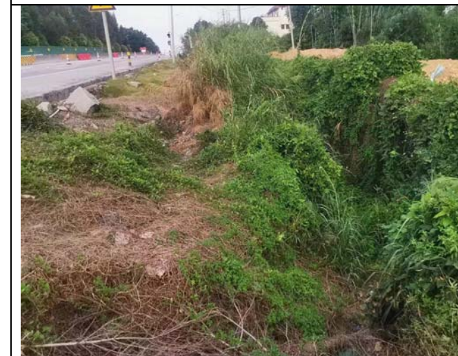
现场照片 5(路基边坡)
