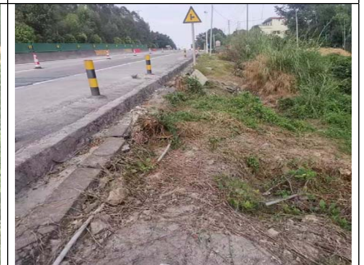
现场照片 6(排水边沟)
