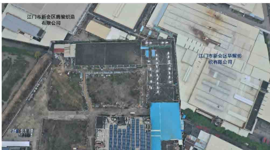
西南面——江门市新会区腾骏织造有限公司
