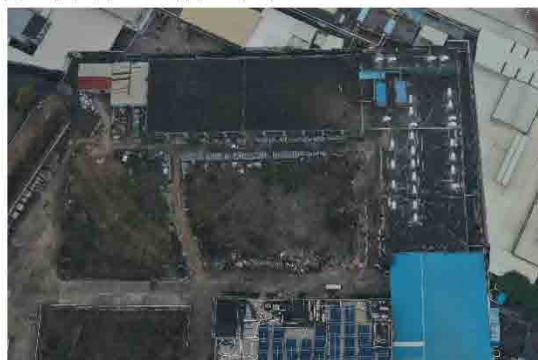
现有项目—洗水车间、固体废物暂存点
