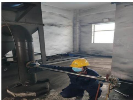
图 7 燃煤破碎出口粉尘的 5#除尘器(处理前)
