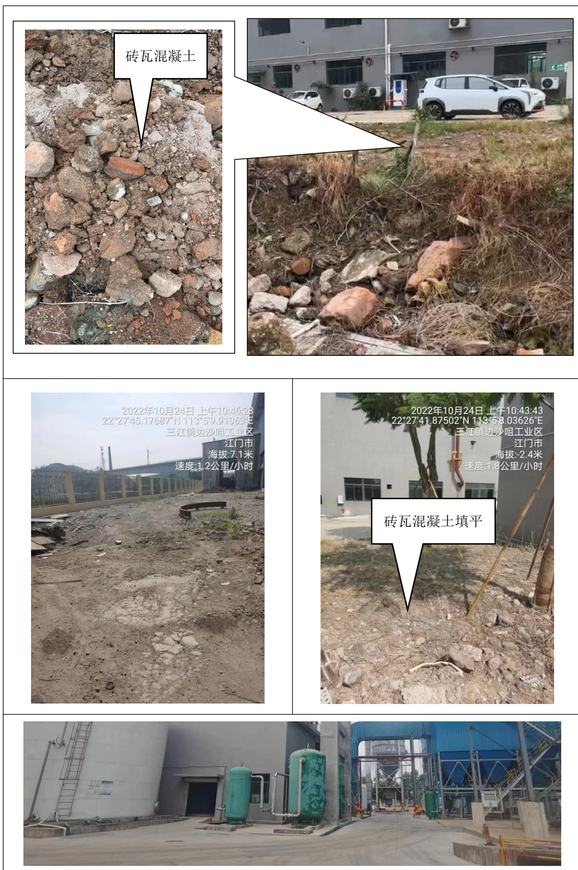
图 6.7-2 厂内场地现状情况
