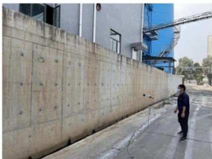
图 25 北面厂界外 1m 处▲1
