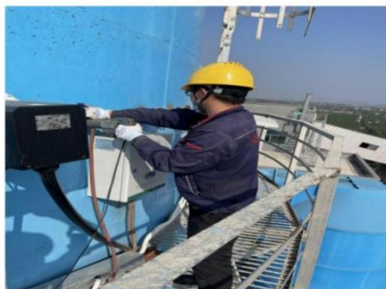
图 19 锅炉烟气排气筒（处理后）◎8
