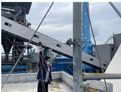
图 3 1#输煤转运站粉尘 (处理后) ©1
