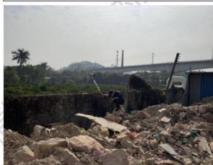
图 28 东面厂界外 1m 处▲4
