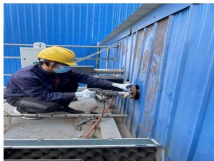
图 18 锅炉烟气排气管道(处理前)
