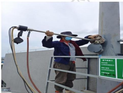
图 5 2#输煤转运站粉尘 (处理后) ©2
