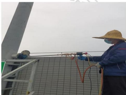
图 11 3#输煤转运站粉尘排气筒采样口 (处理后)◎4
