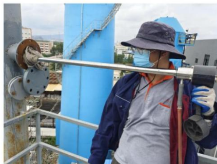
图 14 石灰石粉储存库排气筒采样口 (处理后)◎6
