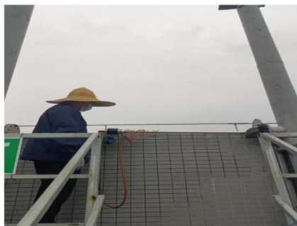
图 12 1#炉前煤仓粉尘排气筒采样口 (处理后)◎5
