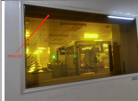
涂布的玻璃罩+无尘车间的微负压夹层
