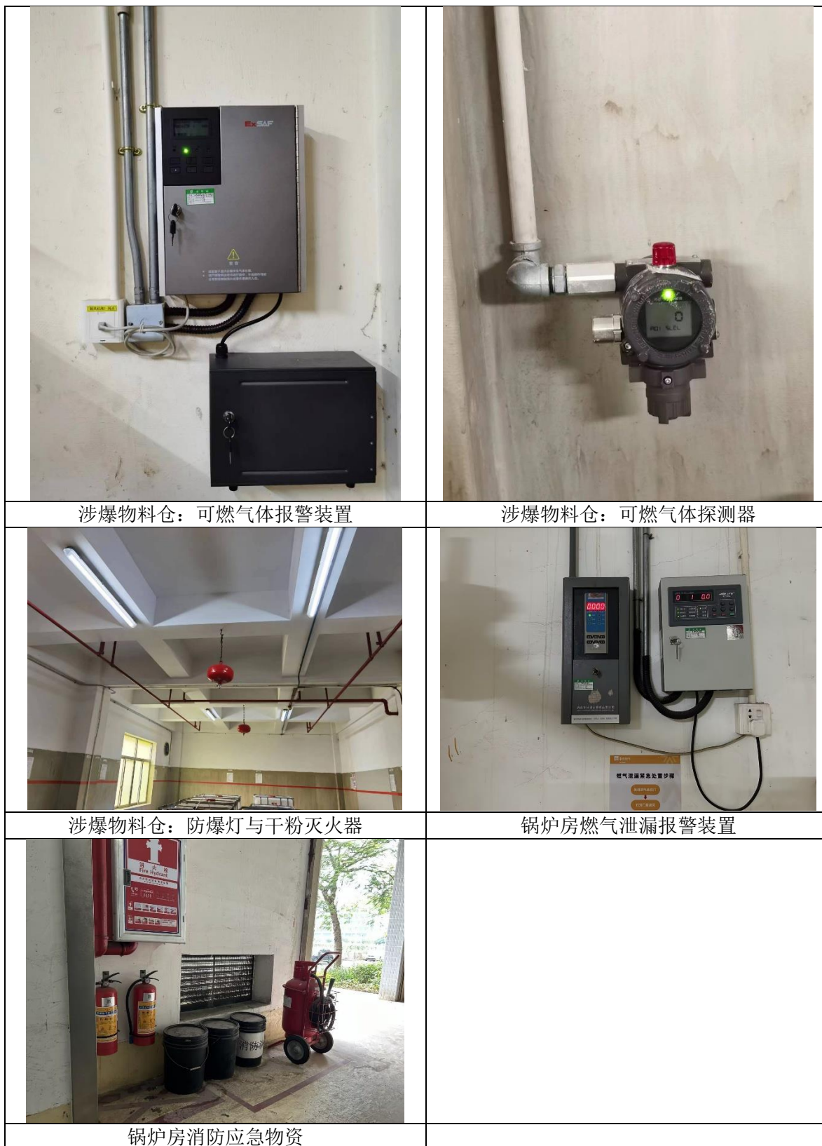
图 3.7-3 化学品泄漏探测与报警系统照片
