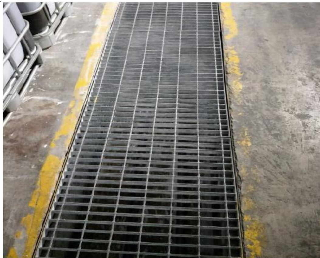
车间内泄漏截留沟
