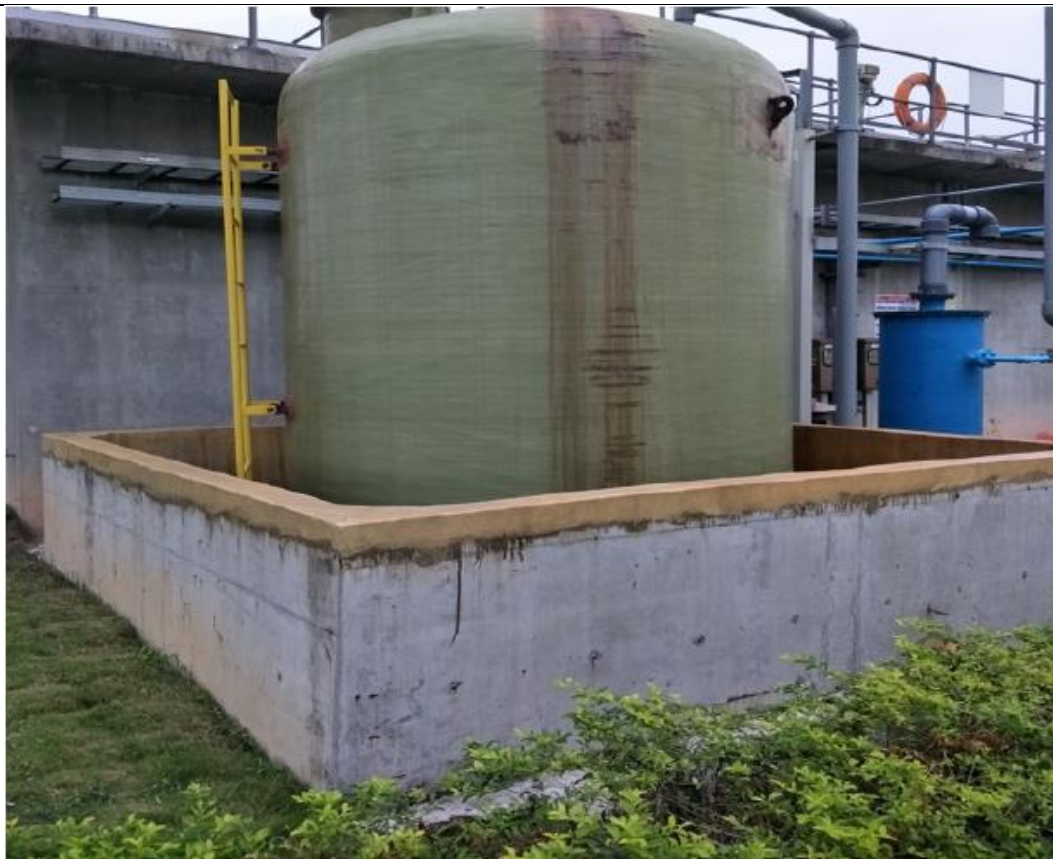
污水处理站酸罐围堰
