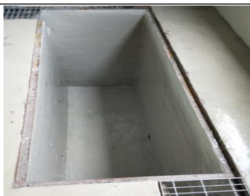
危废房收集池防腐防渗
