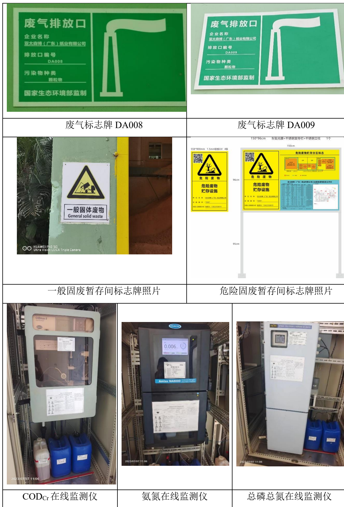
图 3.2.3-1 现有项目部分环保设施图片
