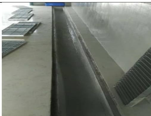
危废房应急收集渠道防腐防渗
