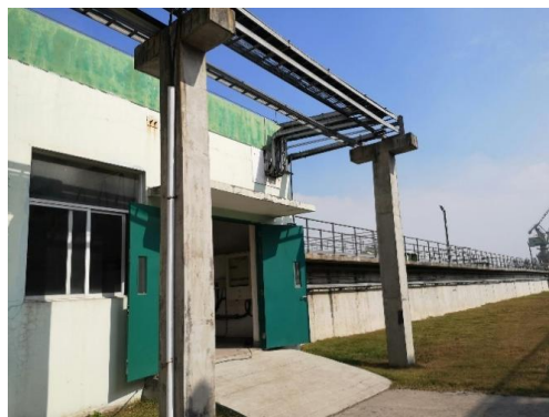
调节池提升泵房
