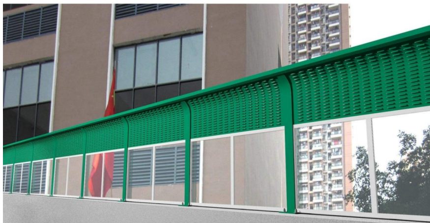
图 8.2-1 直立式声屏障工程实例图
