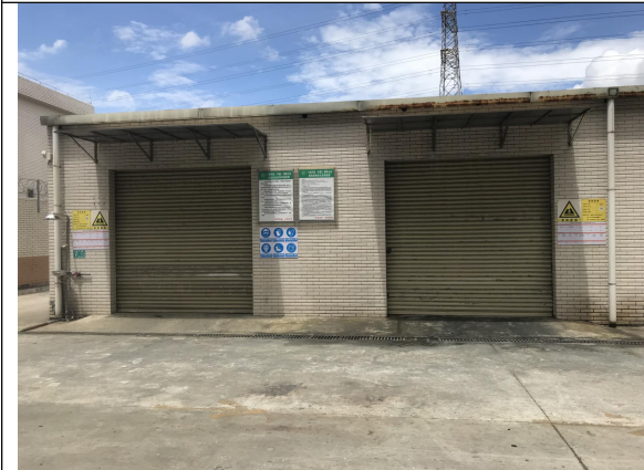
危险废物仓库
