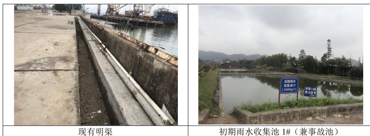
图 5.2-3 本项目初期雨水收集池
