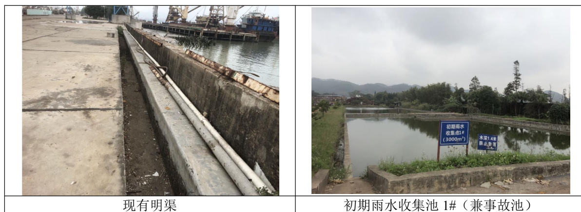
图 6.3-3 本项目初期雨水收集池
