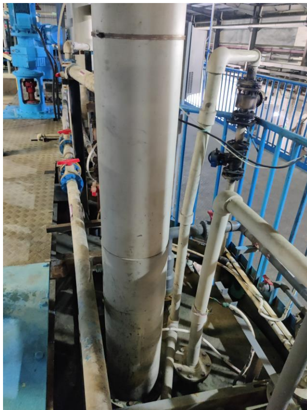
图 3.9-3 浸出车间溶料废气收集方式
