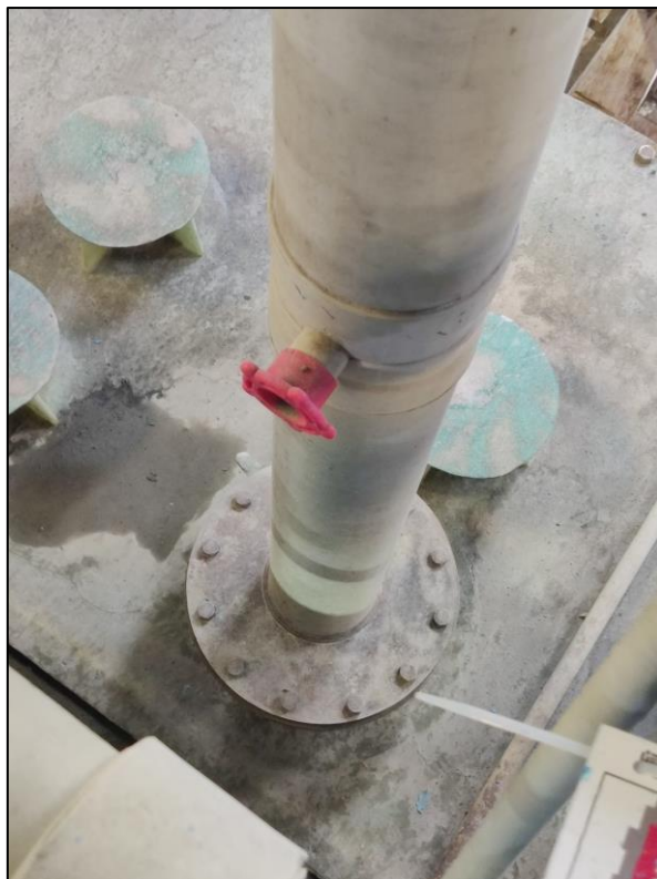
图 3.9-2 原料仓库废气收集方式
