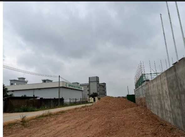
南侧恩平市金图泰物资配送有限公司
