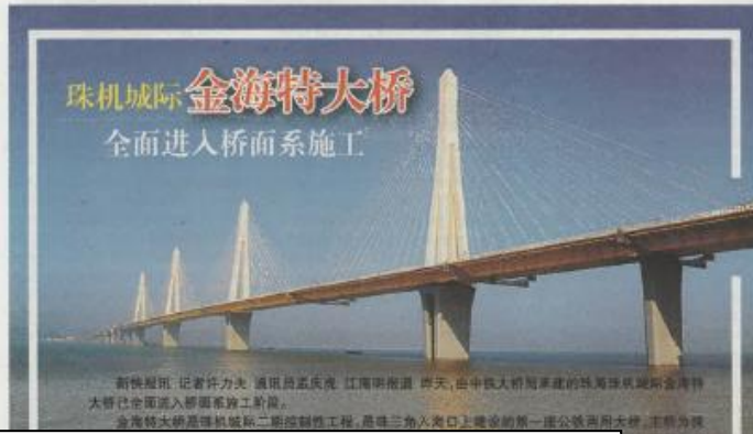
新快报讯 记者许力夫 通讯员吴庆良 江南明报道 昨天,由中铁大桥局承建的珠海机场至金湾特大桥江全面进入桥面系施工阶段。
