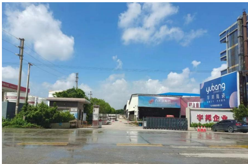
项目西侧 恩平市会德丰陶瓷有限公司
