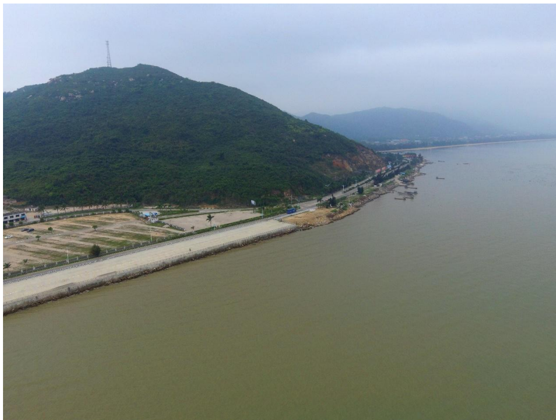
图 5.1.2-2 停车场临海挡土墙现状图
