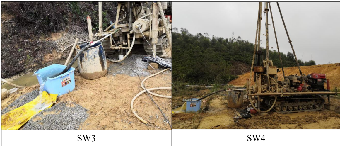
图 5.5-18 抽水试验现场
