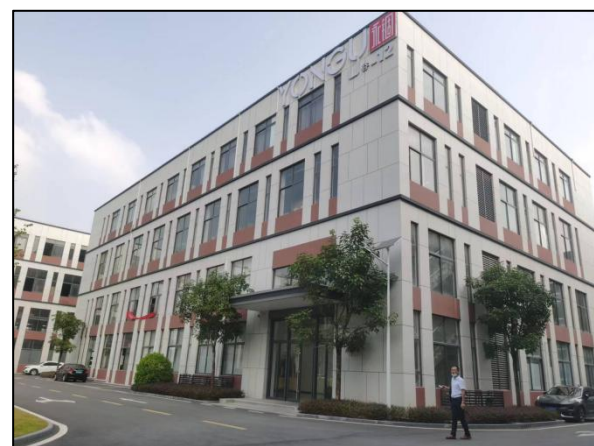
项目所在建筑-12#厂房
