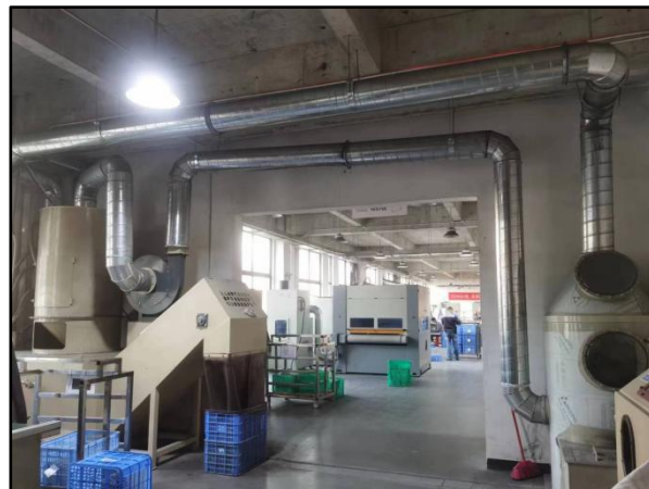
喷砂机配套的除尘器
