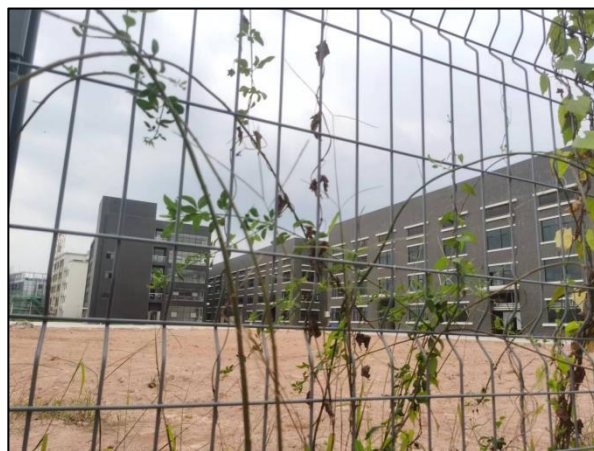
项目东北侧-在建厂房
