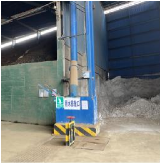
雨水排放口及闸门
