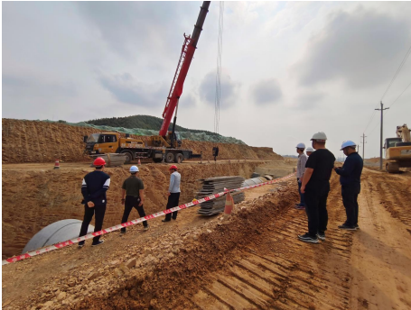
开平市住房和城乡建设局检查“开平市国际卫浴创新基地建设项目（西片区工程）”
