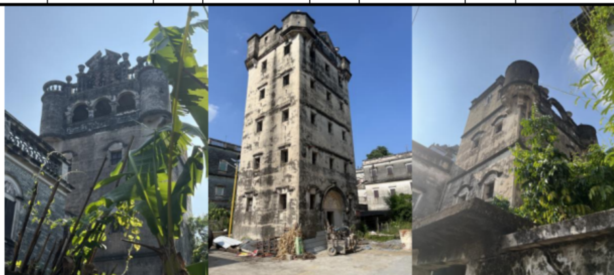
图 4.6-5 缓冲区内碉楼
