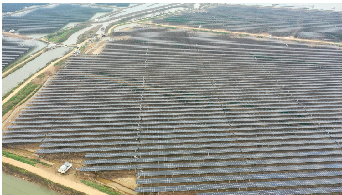
图 2.1.3-2 项目建设现状（光伏区航拍，自南向北）
