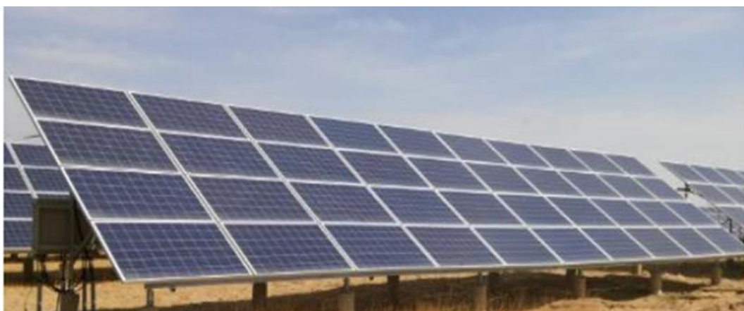
图 7.3.1-2 光伏组件竖向布置 4x 横向布置实景图
