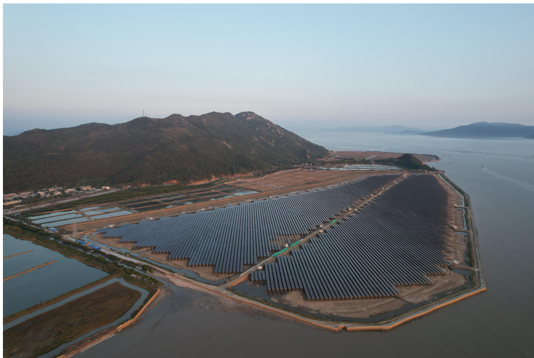
图 3.4.2-2 广东台山海宴镇 200MW p 渔业光伏发电项目
