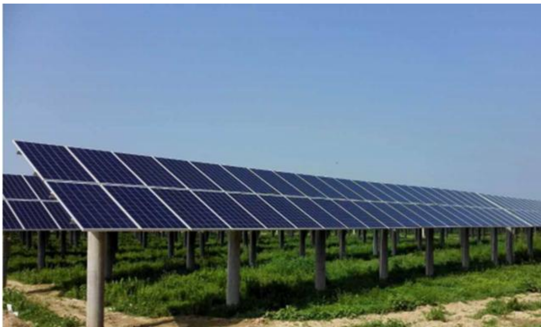
图 7.3.1-1 光伏组件竖向布置 2x 竖向布置实景图
