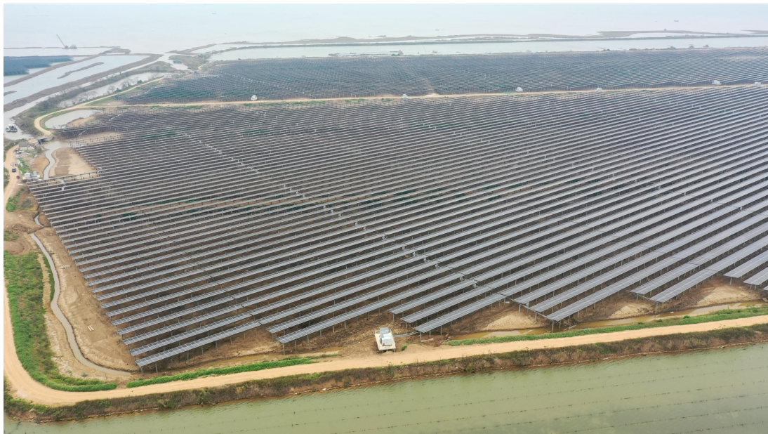
图 2.1.3-1 项目建设现状（光伏区航拍，自北向南）
