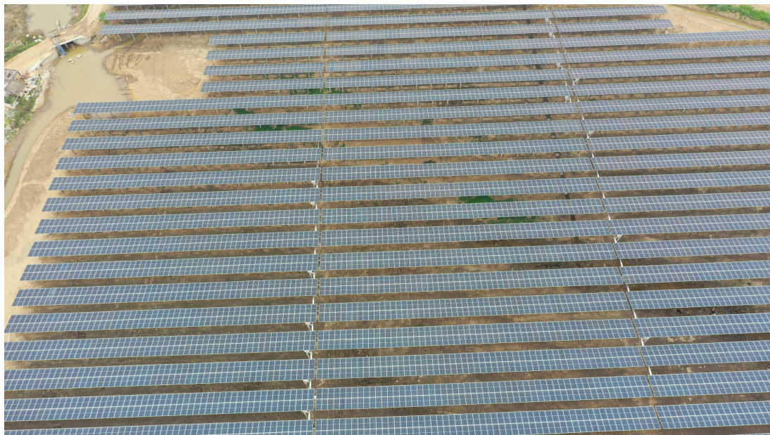
图 2.3.3-2 项目建设现状照片（光伏区）
