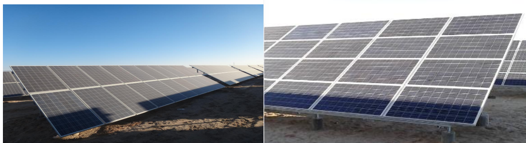
图 7.3.1-6 光伏组件早晚遮挡现场示意图（冬季明显）
