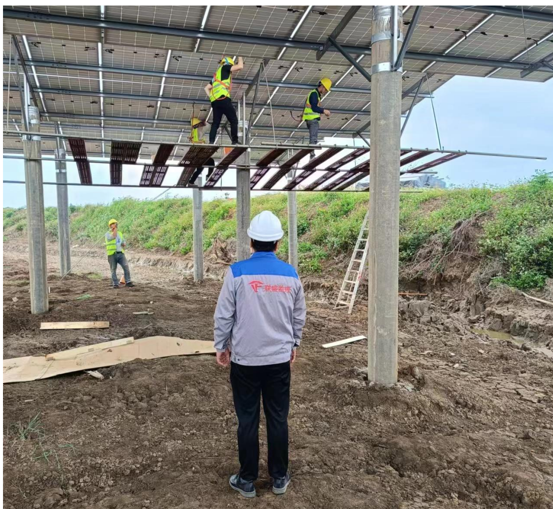
图 2.3.3-1 项目建设现状照片（光伏板施工）
