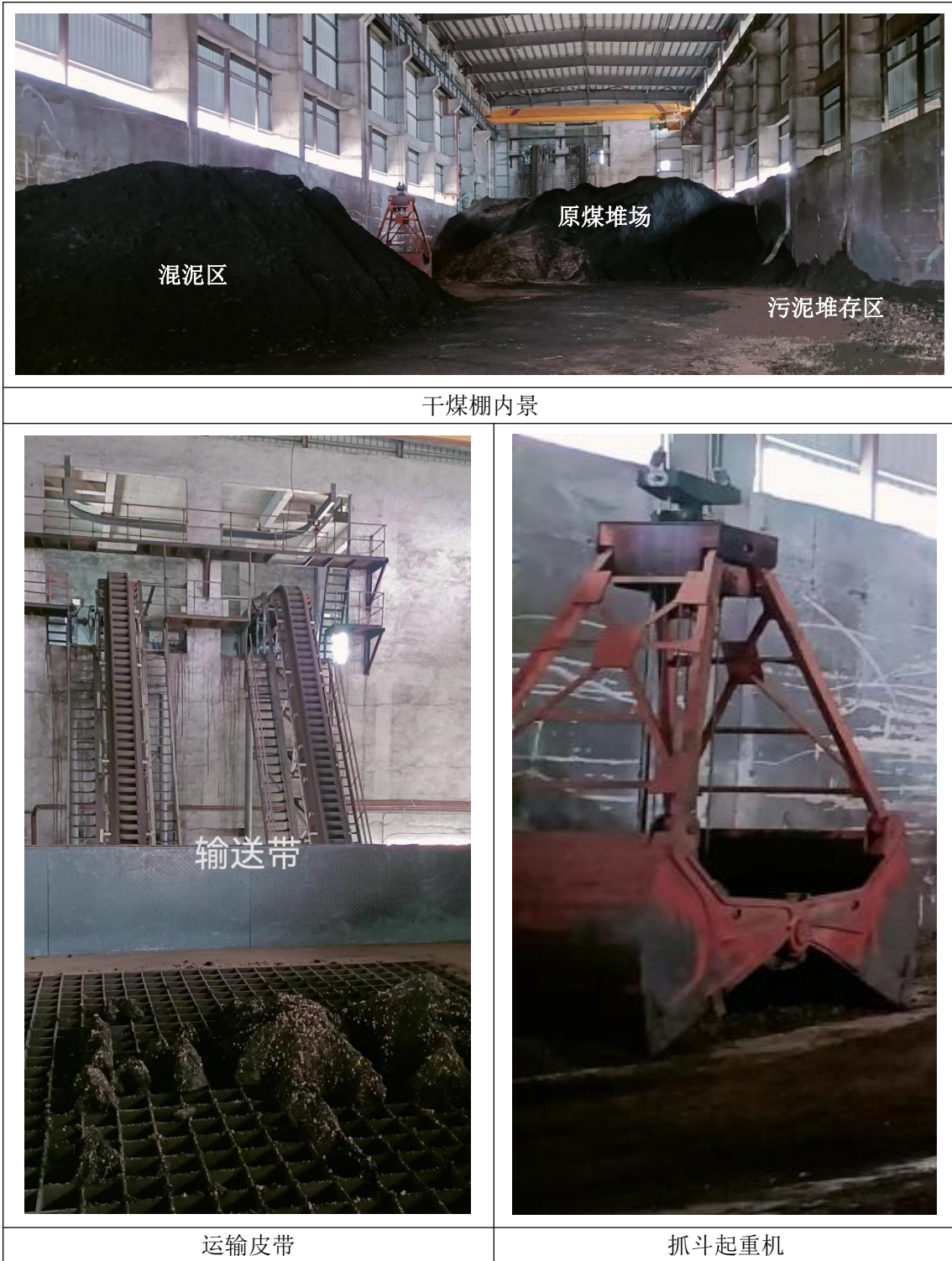
图 4.1-2 干煤棚内景照片
