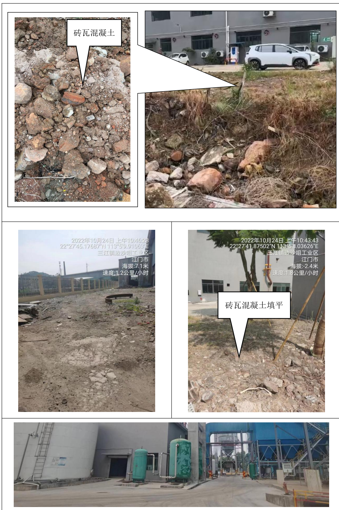
图 5.7-2 厂内场地现状情况
