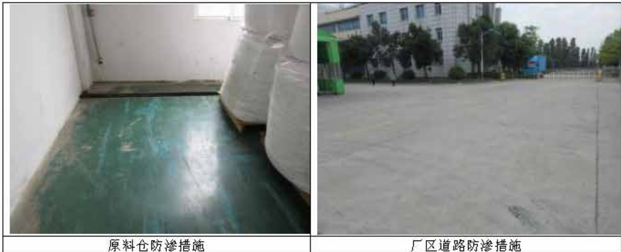
图 4-22 现有工程一般防渗区照片
