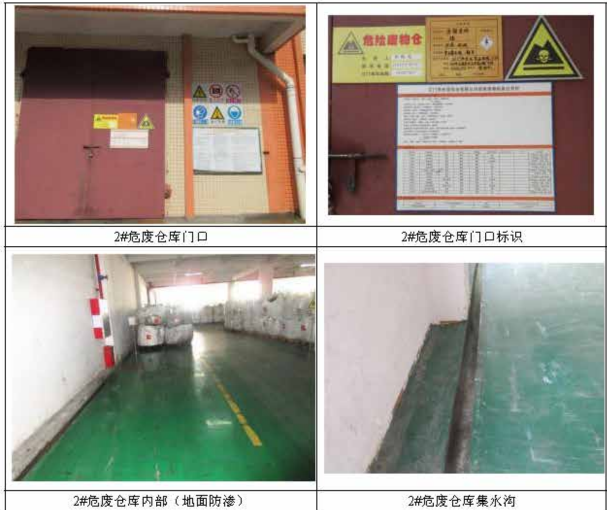
图 4-20 现有工程危险废物仓库图片
