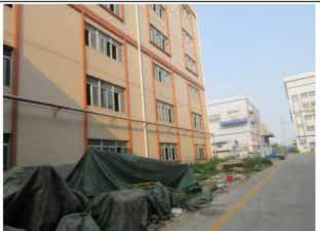
S 罐区（现状为空地，本次改建拟新增 S 罐区）
