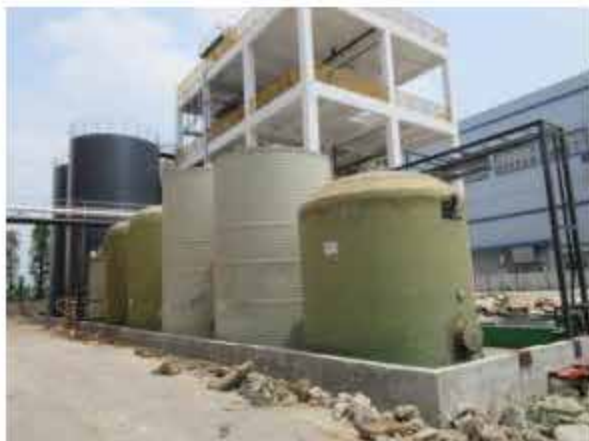
2#MVR 区域（本次改建拟在 2#MVR 区域内增加一些配套的储罐）
