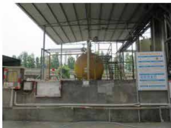
P 罐区（本次改建拟拆除液氨储罐，同时增加 2 个氨水储罐）
