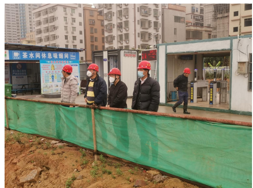
鹤山市住房和城乡建设局检查“联东U谷·江门鹤山国际企业港二期建设项目”“祥和花园（二期）-13座、14座、15座”
