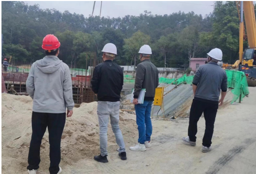
开平市住房和城乡建设局检查“开平市第三人民医院新建住院综合大楼及配套项目”
