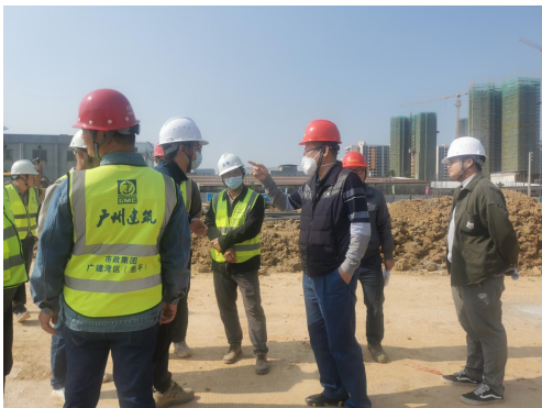
恩平市住房和城乡建设局检查“恩平市实验小学和实验幼儿园建设项目”
