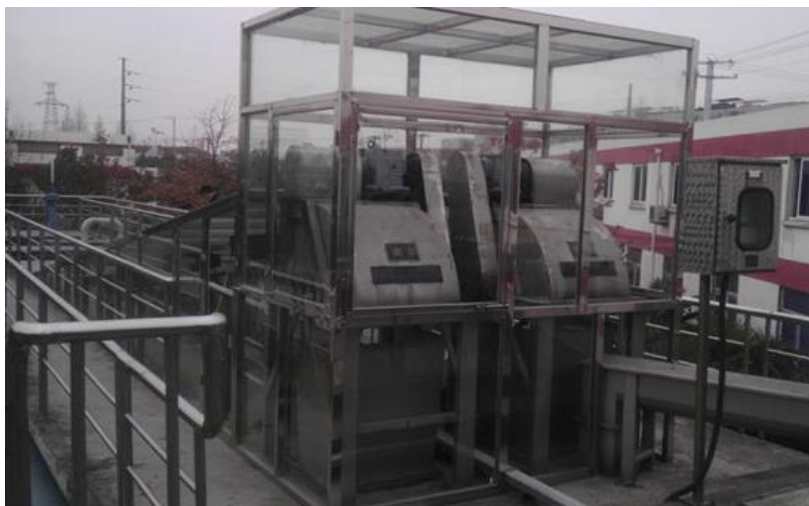
图 4.4-8 PC 耐力板+不锈钢方管骨架罩
