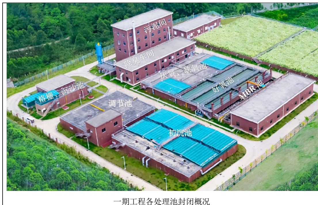
图 3.5-1 现有工程各处理池封闭照片
