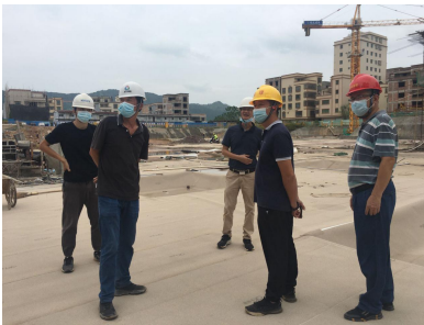
恩平市住房和城乡建设局检查“汇银江南富湾项目高层住宅六期建设”
