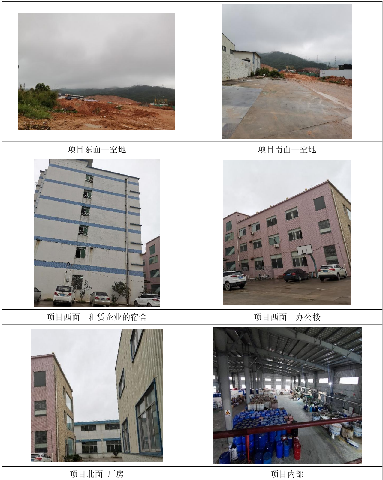
图 3.1.3-2 项目四至情况实景图
