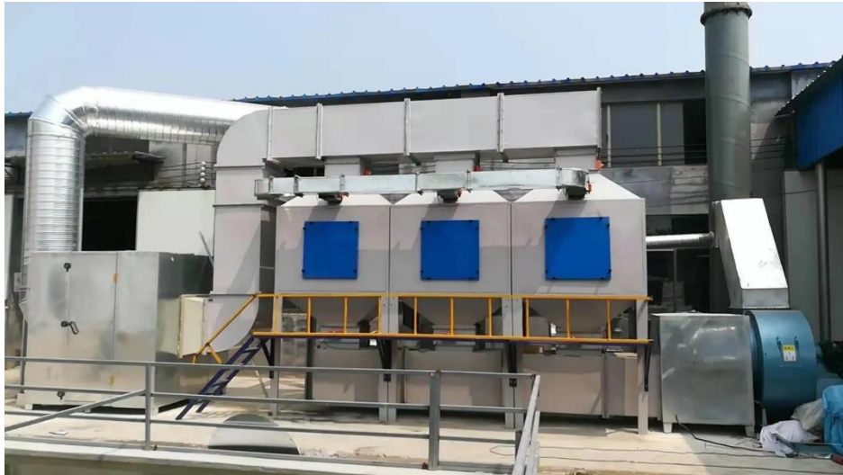
图 7.2-2 活性炭吸附浓缩+脱附 CO 装置示意图
